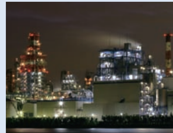
水江工場重質油分解装置
