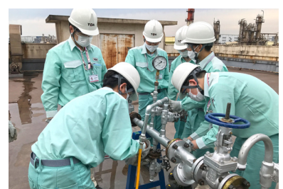
配管操作実習の様子
